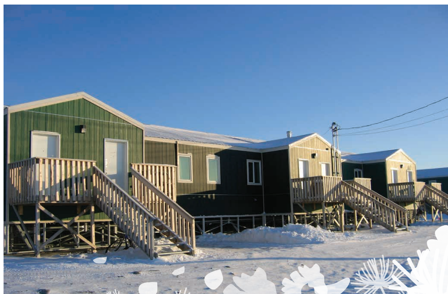
© Crédit : La Société canadienne d'hypothèques et de logement (SCHL), Quintuplex de la Société d'habitation du Nunavut – Arviat (Nunavut)
